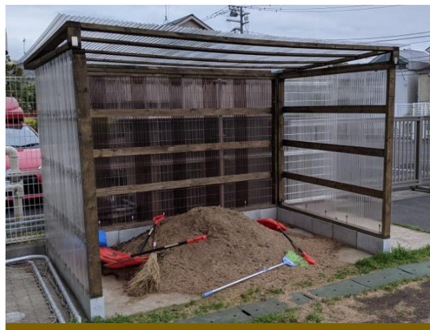
南グラウンドに完成した堆肥小屋
